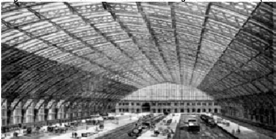
Fotografia 9 Estación Saint Pancras - Londres – Inglaterra W. H. Barlow (1864)
