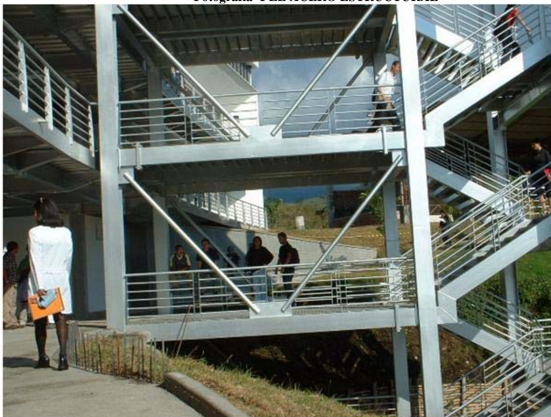
Figura 2.7 uniones, arriostramientos en estructura de acero, UN La Nubia
